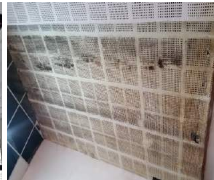
पानी चुहिएर मक्केको हलको पर्खाल
