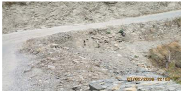
पहिरोको कारण भत्किएको पर्खाल र विग्रीएको ओटासिल
